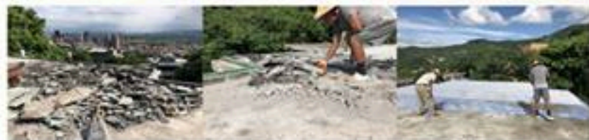
8/22 兩院教學大樓屋頂修繕工程開始進行
